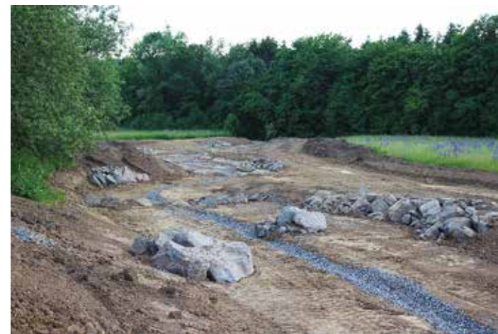
Bild oben: ein breiter Streifen neben dem noch kleinen Bachlauf soll für einen Lebensraum sorgen, der für solche Gewässers typisch ist. Bild unten: Die Neugestaltung der Quellfassung ist fast fertiggestellt. Fotos: Hans-Jürgen Pletz
